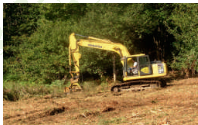
Travaux d'ouverture du milieu
