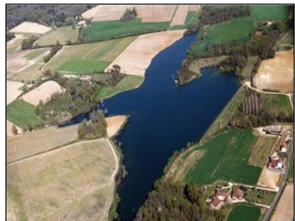
Figure 8 : Retenue collinaire de Lagrange et Creon-d'Armagnac (source : http://sites-nature.aquitaine.fr )
